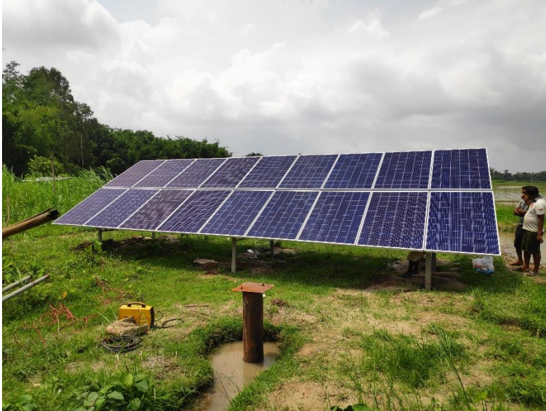
NITP अन्तर्गत हेंगा टोली सोलार सि.यो., गौरादह, झापा को Solar Pump सहित को Tubewell
