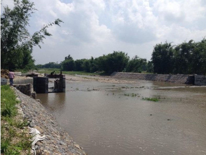
मझौला सिंचाइ अन्तर्गत हडिया फूलबासा सि.यो., बुद्धशान्ति, झापा को हडिया खोलामा निर्माण सम्पन्न भएको Core Wall Type हेडवर्क्स
