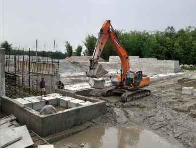
अदुवा खोला सि.यो., बाह्रदशी - हेडवर्कस) निर्माणाधिन
