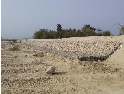
सतासी खोला नदि नियन्त्रण कायै
